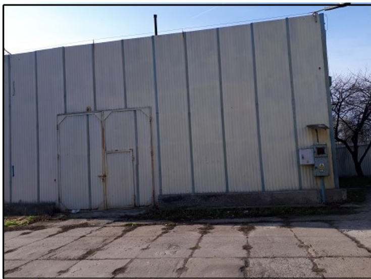
Rysunek 1. Widok elewacji budynku.
